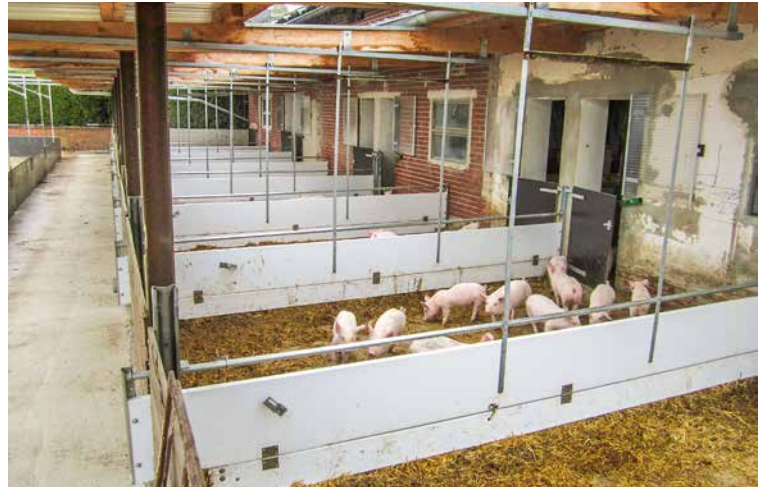
Für die ökologische Ferkelaufzucht ließen sich Altgebäude gut nutzen. Ein großzügiger Auslauf wurde an das Stallgebäude angefügt.
